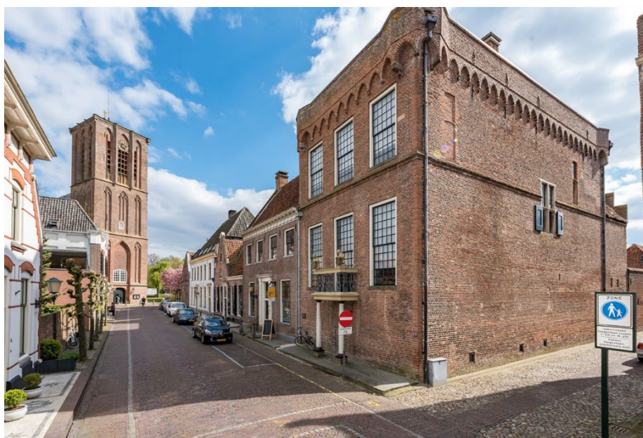
In de twee panden rechts op de voorgrond is het Nationaal Orgelmuseum gevestigd.
